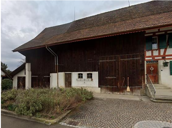
Zustand vor dem Brand, Foto Google street view
