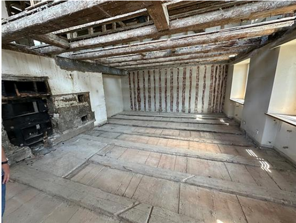
Stube, Blick nach Osten, Foto Diego Schaub 2025. Balkendecke über dem Keller mit eingeschobenen Bohlenbrettern
