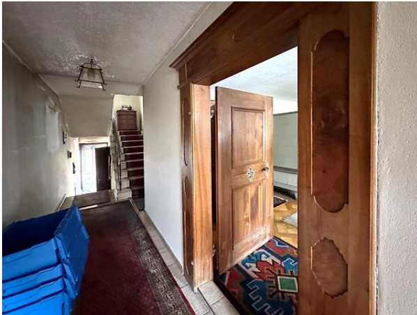
Eingangshalle und barocke Tür zur Stube, Foto Daniel Schulz 2025
