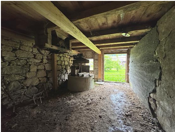
Anbau vor dem Kellereingang, Foto Daniel Schulz 2025
