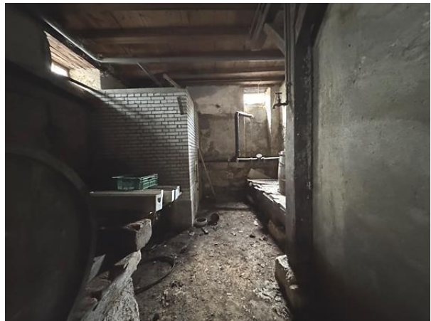
Keller, Blick nach Westen, Foto Daniel Schulz 2025
