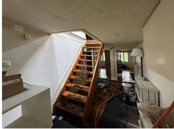
Flur im Obergeschoss und Treppe zum Dachboden, Foto Daniel Schulz 2025
