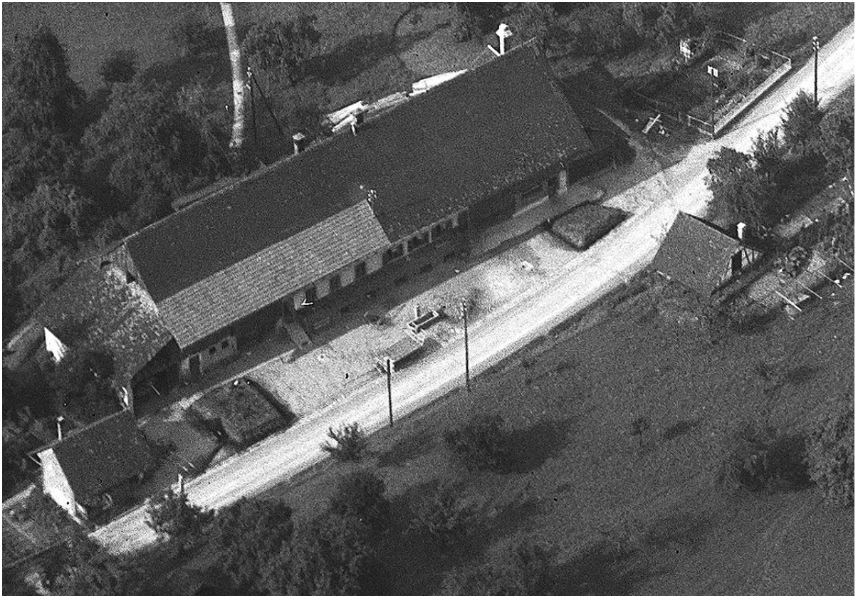
Luftbild 1948, Werner Friedli, ETH e-pics LBS_H1-010897 – Ausschnitt. Beide Ökomieteile besitzen nur Tenn und Stall. Der ursprüngliche Vielzweckbau war also kürzer als der heutige. An den Giebelseiten ist jeweils eine Remise angebaut.
