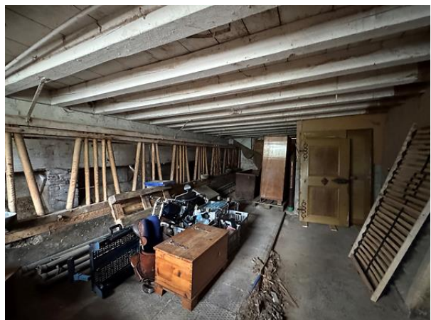
Stall, Blick nach Norden, Foto Daniel Schulz 2025. An der linken Wand Futtertrog und Futteröffnungen zum Tenn.
