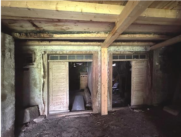
Kellereingang von der Nordseite, Foto Daniel Schulz 2025. Der rechte Eingang führt in den Keller der Nr. 10.
