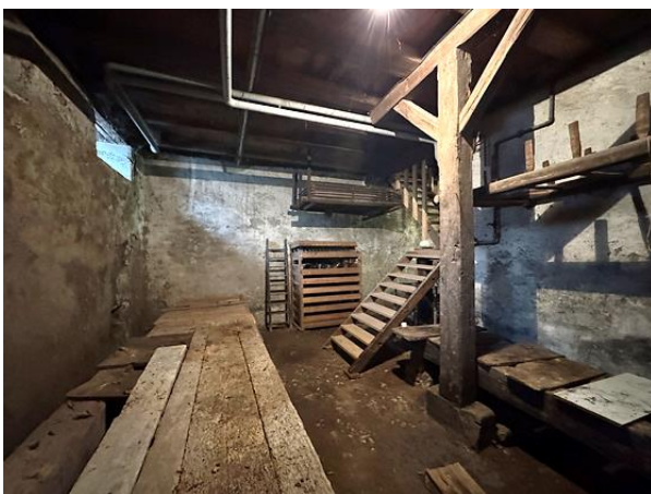
Strassenseitiger Keller, Blick nach Westen, Foto Daniel Schulz 2025
