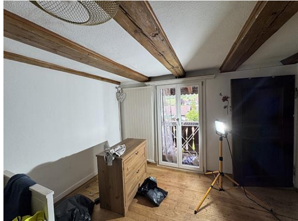
Obergeschoss Zimmer 3, Blick nach Norden, Foto Daniel Schulz 2025
