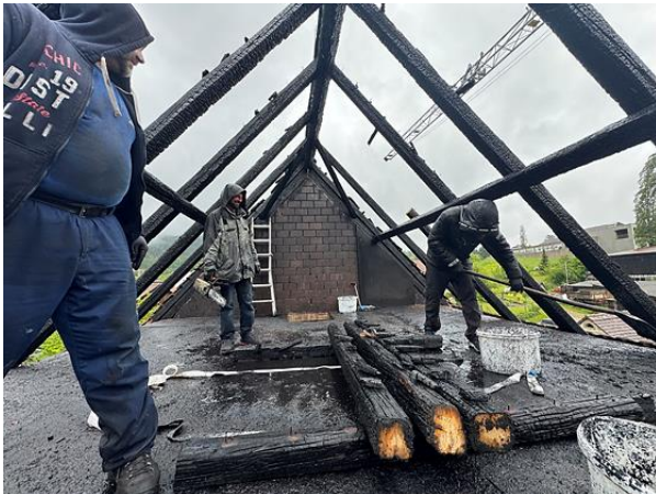
Dachgeschoss, Spitzboden, Blick nach Osten zum Ökonomieteil, Foto Daniel Schulz 2025
