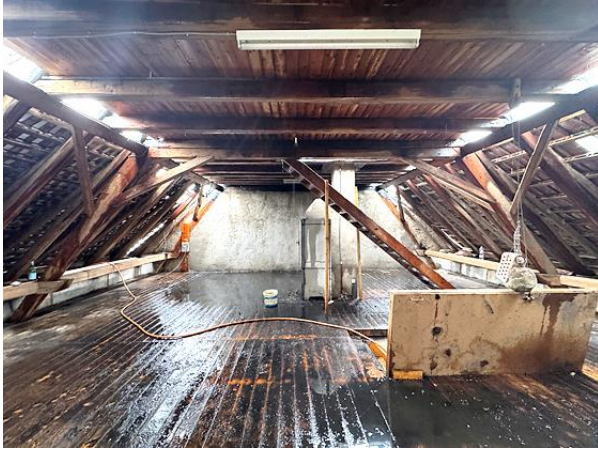
Dachgeschoss, Aufgang zum Spitzboden, Foto Daniel Schulz 2025
