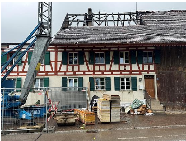
Ansicht des Hausteils, Foto Daniel Schulz 2025.
