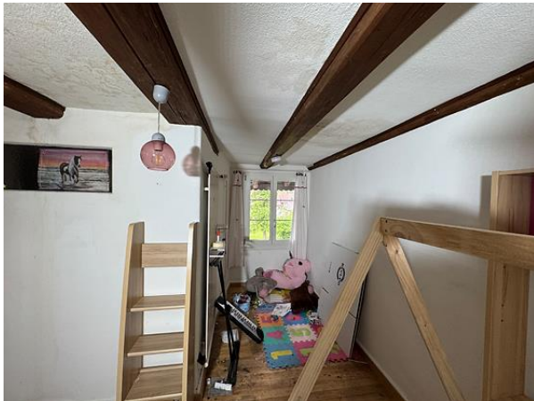
Obergeschoss Zimmer 2, Blick nach Norden Foto Daniel Schulz 2025
