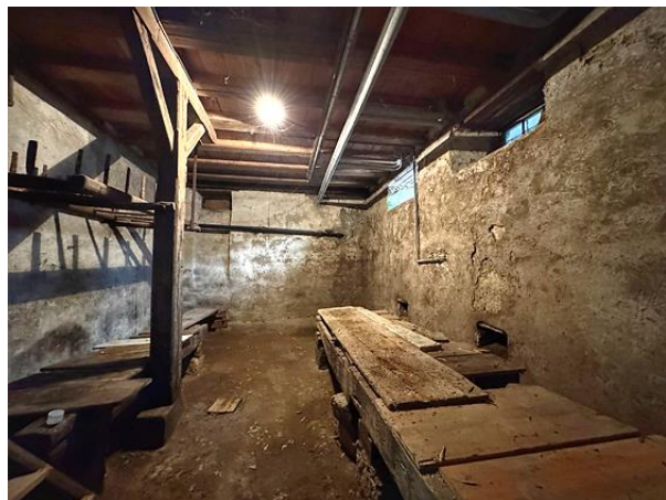
Strassenseitiger Keller, Blick nach Osten, Foto Daniel Schulz 2025
